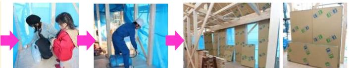
上棟式では、お施主様に家の四隅を酒・米・塩でお清めしていただきました。最後に、柱の床から1mの部分をお清めしていただき、外周までしっかりと防蟻処理を行います。翌日は、壁と屋根に**FPパネル**をハンマーでぴったりとはめ込んでいきます。その後、気密テープで隙間を完全にふさぎ、徹底した気密処理を行い、高気密な家を実現します。
