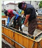
建物の底一面を鉄筋コンクリートの基礎で支えるベタ基礎。入念なチェックを合格し、今回も精度の高い基礎が完成!
