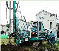
湿式柱状工法セメント系固化材を注入しながら地盤を掘削し、引き上げる際に地盤とセメントを攪拌して強度の高い円筒形の柱を作る工法。
