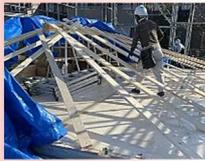
台風が過ぎ、最高の上棟日☆上棟前の土台は床合板の含水率を合格値でキープするべく写真のような状態で養生しています。
