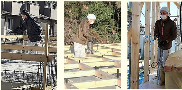
①土壌処理 ②土台施工後 FP床パネル施工前 ③上棟
