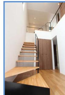
階段の段板は無垢、手摺りと柱は鉄骨の組み合わせ。階段横の側板をなくした片持ち階段にし、シンプルを極めたデザインです。鉄骨のブラックが空間を引き締めて、シャープな印象になっています。
