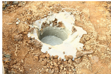
① 杭心位置を合わせる。 ② 掘削ロッドを回転させながら、所定深度まで挿入する。 ③ セメントミルクを吐出しながら引上げる。 ④ 完了
