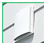
建物外部に取付けられた給気口。
