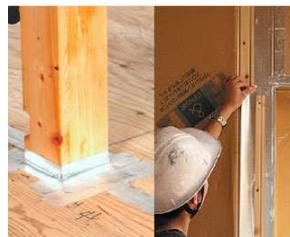
気密の精度を高めるため、湿気や空気を通さない断熱材「FPウレタン断熱パネル」を使用。柱とパネルの継ぎ目は、さらに気密テープを貼り付けて密閉されます。気密テープはパネルと柱・梁との接合部はもちろん、窓などの開口部にも貼られ、徹底した気密対策を図ります。
