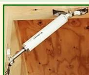
地震の揺れを吸収する制震装置の中でも、抜群の性能を持つ【ウィンダンパー】を採用。
