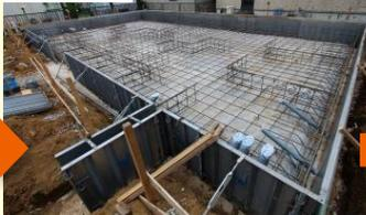
家をしっかりと支える基礎にするため、基礎工事完了後と土台施工後に100箇所以上水平レベルチェックを実施。厳しい2重のチェックを行っています。
