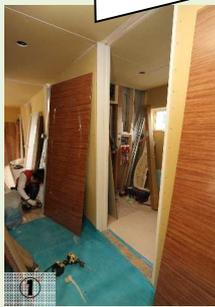
ユニットバスの壁にパネルの角を合わせながら貼り付けていきます。
