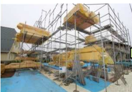
AM8:00～作業開始！鉄筋で足場を作ります
